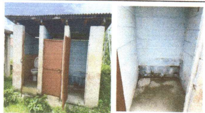
Foto 10: Sustitución inodoro, Sustitución Lavamanos
