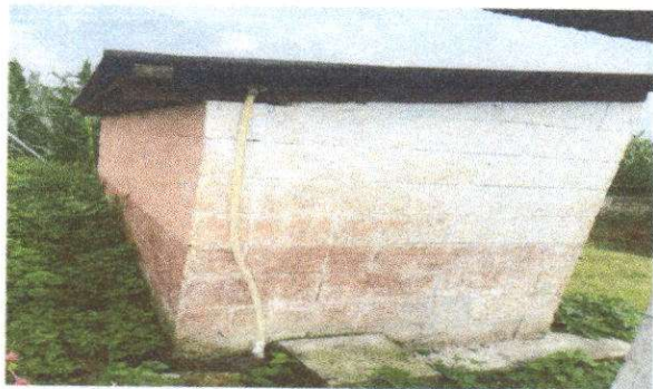
Foto 9: Repello en muro
