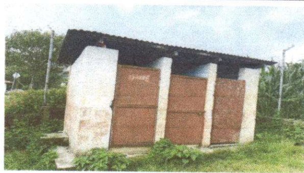
Foto 11: Sustitución puertas en servicio sanitarios
